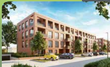
Drei Häuser mit 44 Wohnungen in der Nähe der Seelhorst
